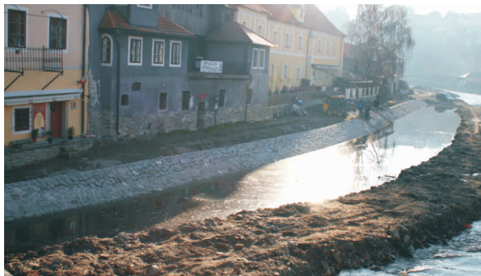
Nově zpevněné břehy za Lazebnickým mostem Foto archiv
