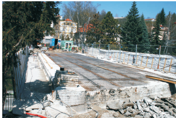
Odkrytá mostovka mostu u kina. Foto archiv
